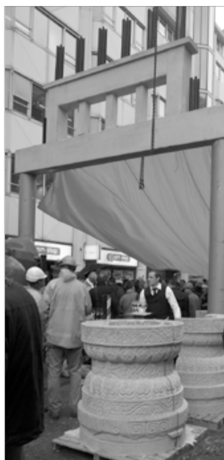
Bij de uitgang van de Bijenkorf in de Wagenstraat worden de kolommen geplaatst bij het staketsel van de poort ...
