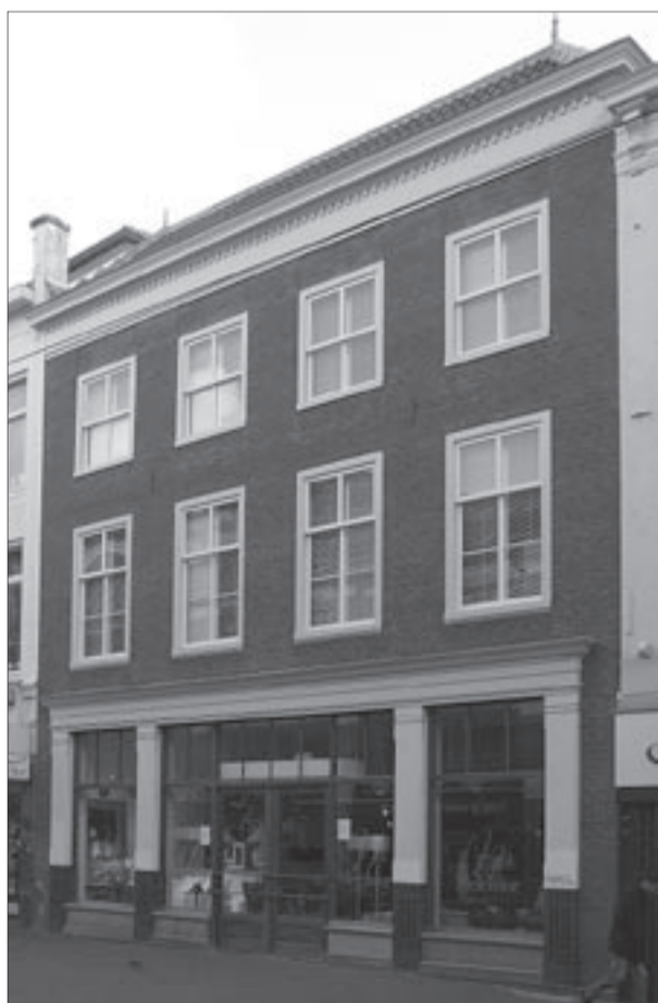
Tevredenheid alom op de Dagelijkse Groenmarkt: een historisch verantwoorde renovatie van de winkelpui van dit pand.
