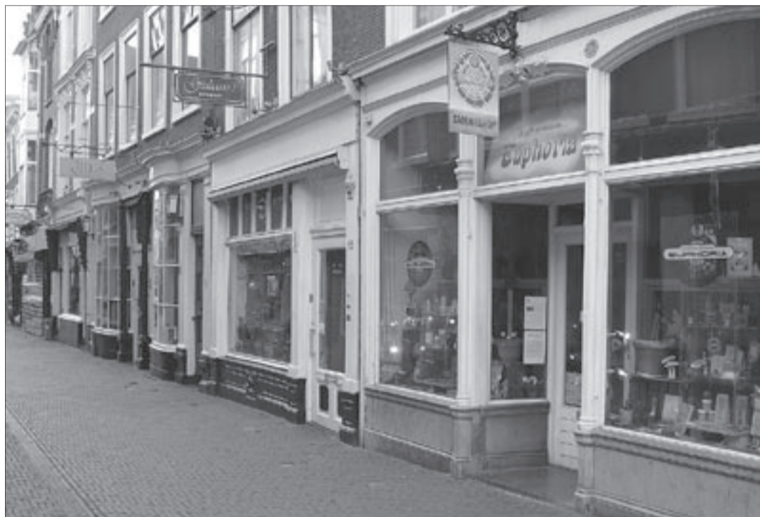
De borstweringen onder de winkervensters vormen eigenlijk de 'plinten' van de straat en geven een prettig straatbeeld. Vaak is er geen borstwering meer aanwezig, maar hier in dit deel van de Schoolstraat is die weer teruggekeerd, dankzij de inzet van een van de winkeliers.
